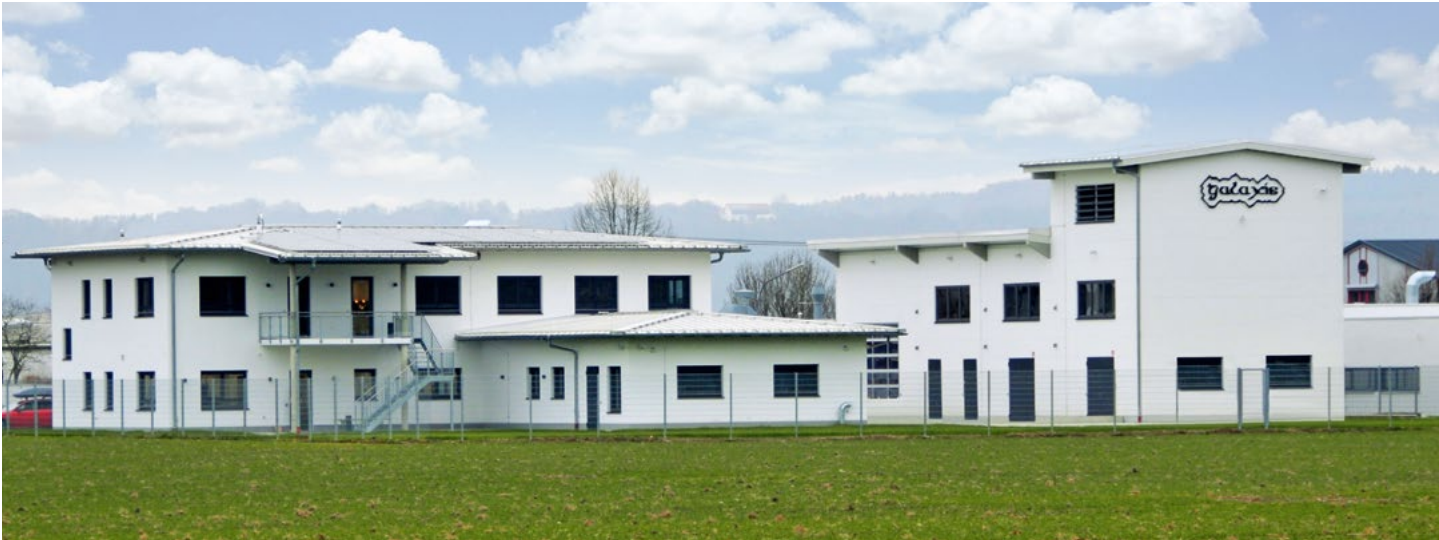
Neu errichtetes Betriebsgebäude der Galaxis Showtechnik GmbH Newly built premises of the Galaxis Showtechnik GmbH
